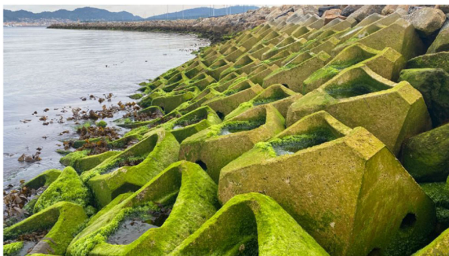
Figura 92. Piezas de hormigón ecológico que aumentan la biodiversidad en una estructura. Puerto de Vigo, 9 meses tras la instalación de las piezas. Fuente: EConcrete.
