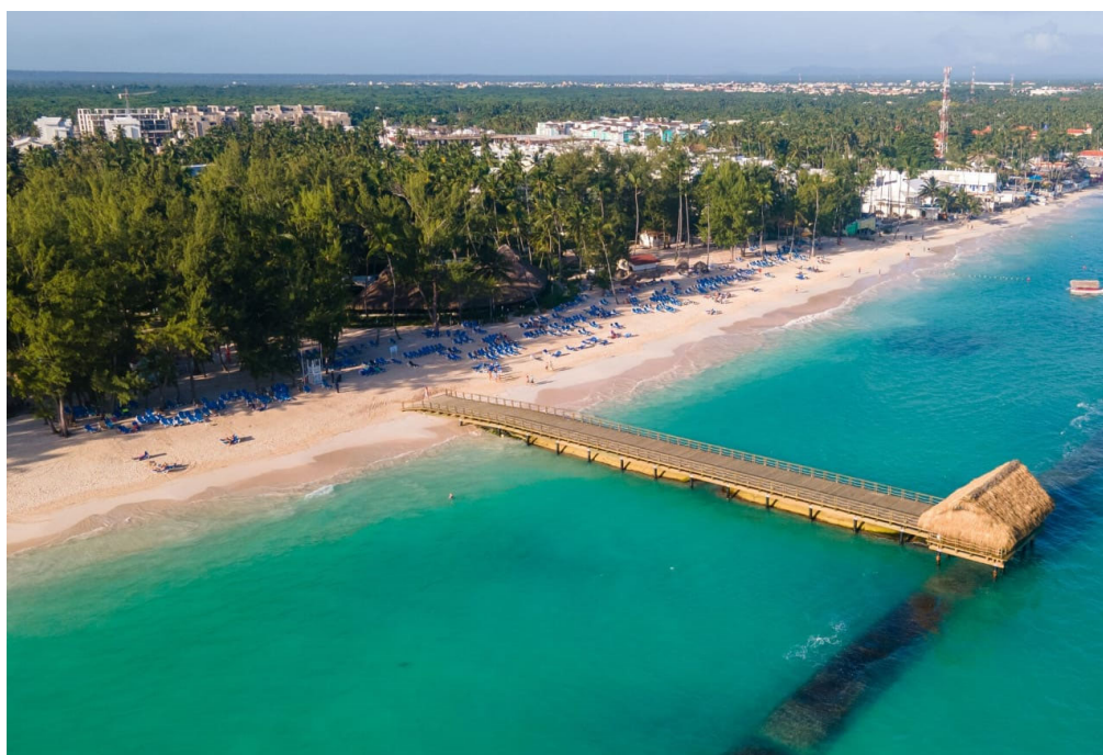
Figura 95. Ejemplo de estructura con geotubos. Fuente: Diario turístico de la República Dominicana arecoa.com .
