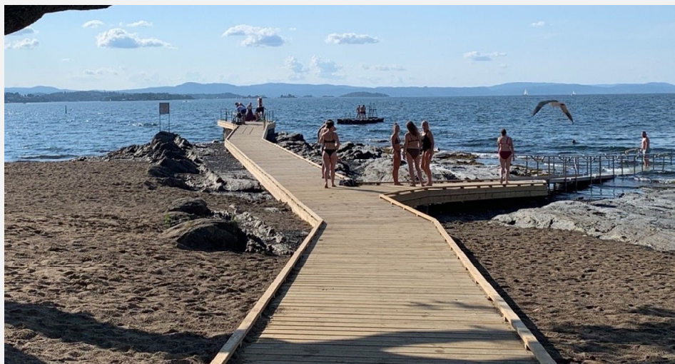
Pasarela en la playa de Hok Oslo, Noruega Østengen & Bergo AS
